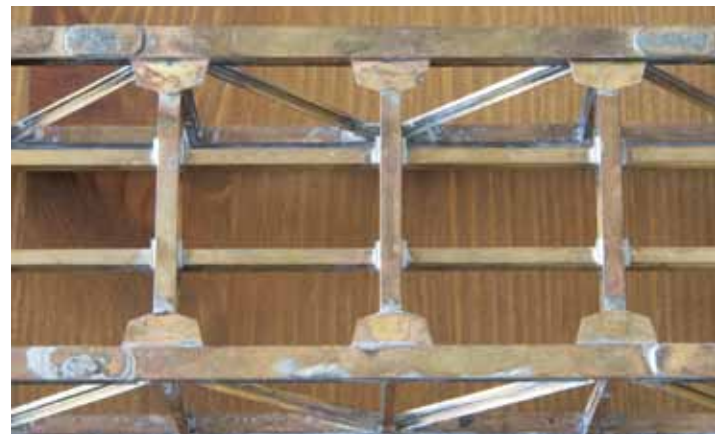
Anbringen der Knotenbleche an der Brückenunterseite. Pose des goussets sur la face inférieure du pont.
