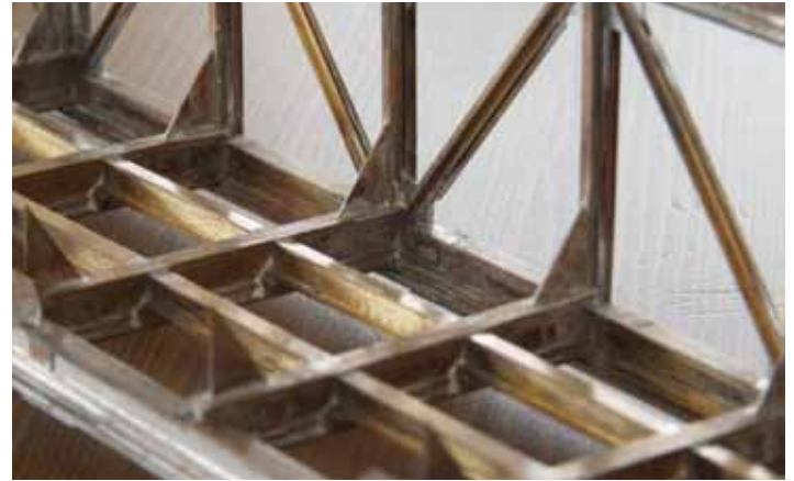
Detailaufnahme der Verbindung zwischen Fahrbahnträger und Seitenteil im Bereich der Querverbindung. Vue détaillée de la liaison entre la poutre de la voie de roulement et la pièce latérale dans la zone du contreventement.
